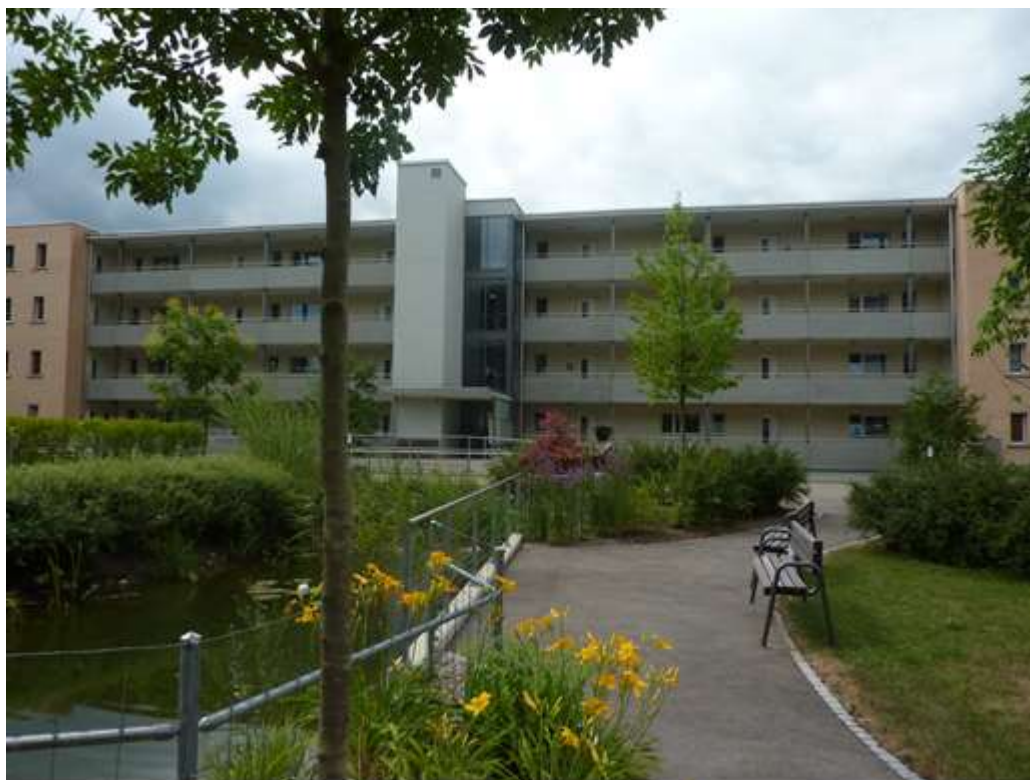
Eingangsseite / Fassade Nordost
