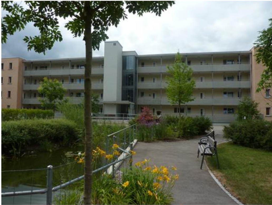
Eingangsseite / Fassade Nordost
