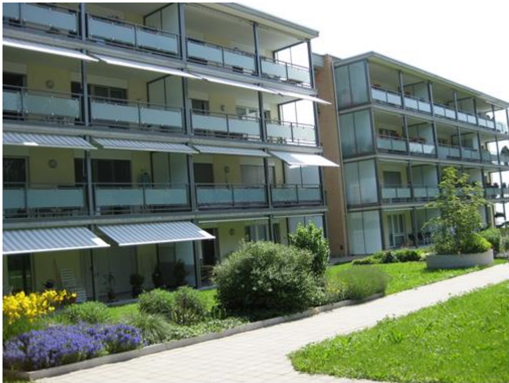
Gartenseite mit Balkon / Fassade Südwest
