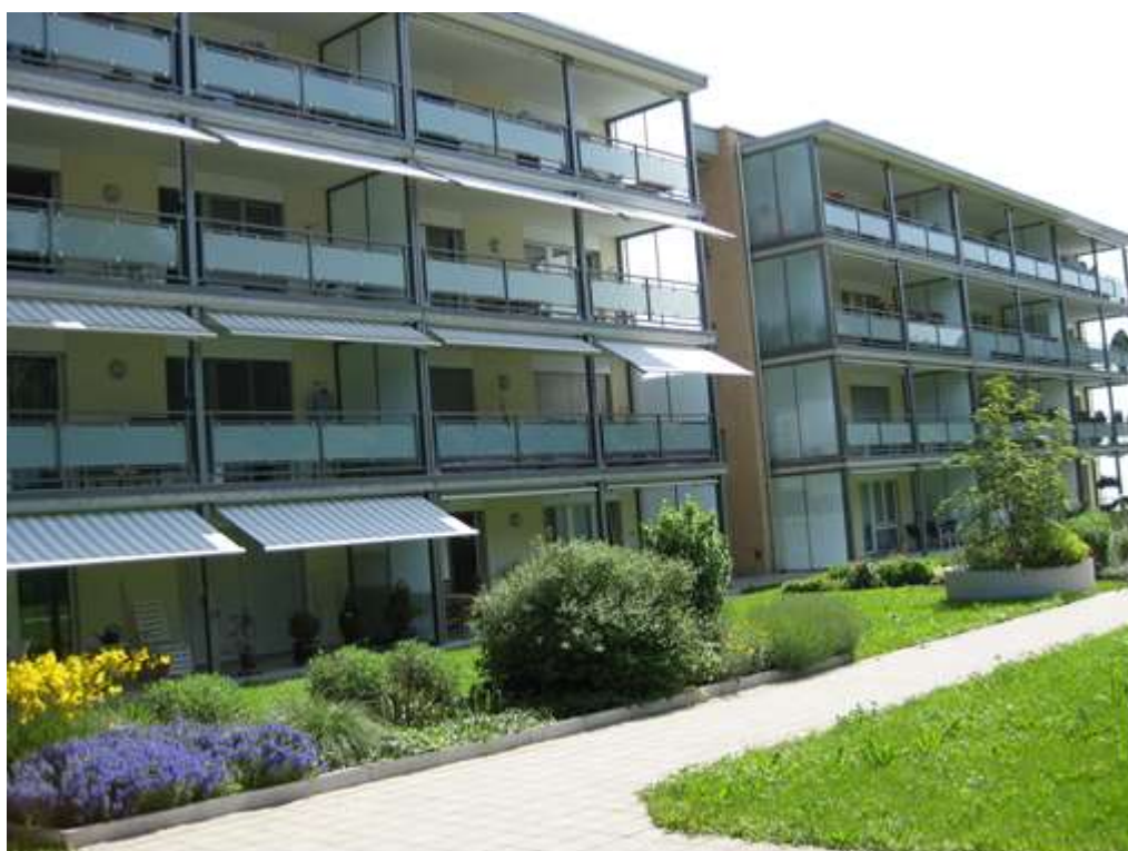
Gartenseite mit Balkon / Fassade Südwest
