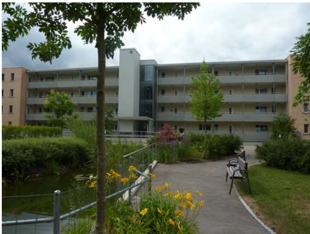
Eingangsseite / Fassade Nordost
